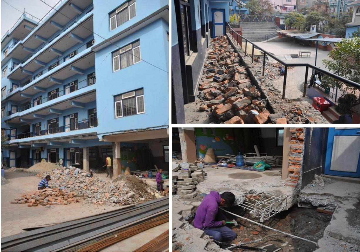
*Die Renovierung der Sozialschule von Nepal Matri Griha läuft auf Hochtouren und soll bis Ende Mai 2016 abgeschlossen sein. Oben links sieht man die T-Träger für die Betongussverstärkung der Wände im Erdgeschoss.*
